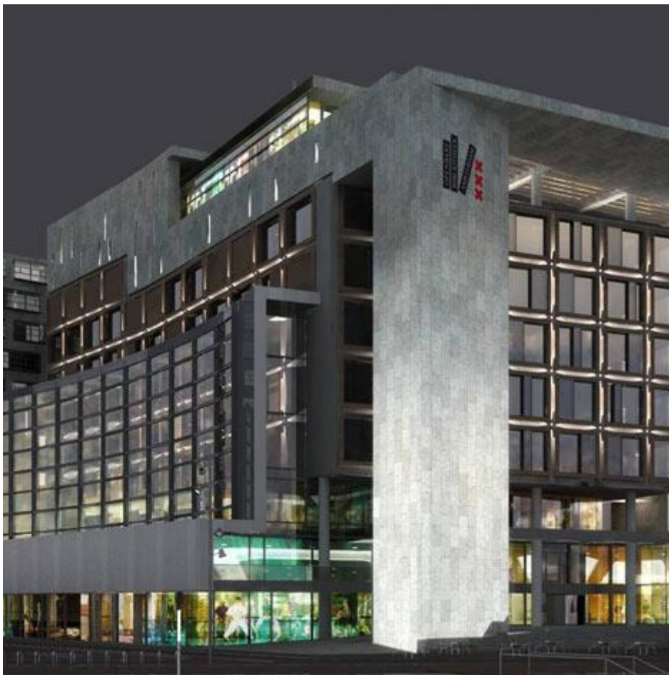
Openbare bibliotheek Amsterdam (nieuw gebouw): uit www.overhoeks.nl/content.php?c=48
